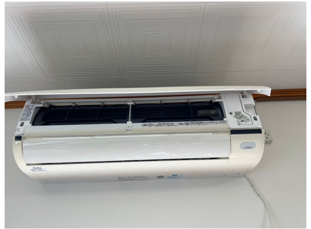
15.エアコンクリーニング
