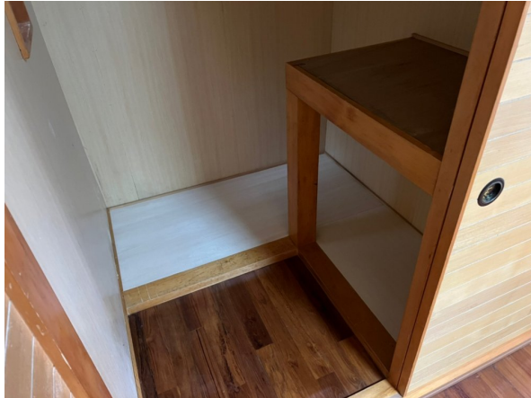
押し入れ下 板張替
