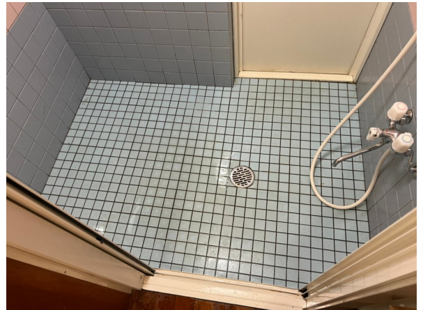
タイル一部補修済み
