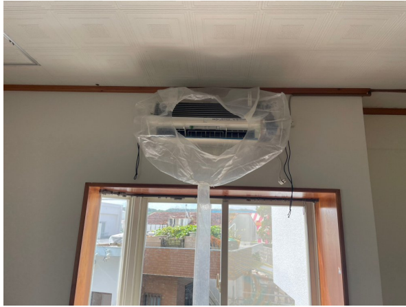
15.エアコンクリーニング
